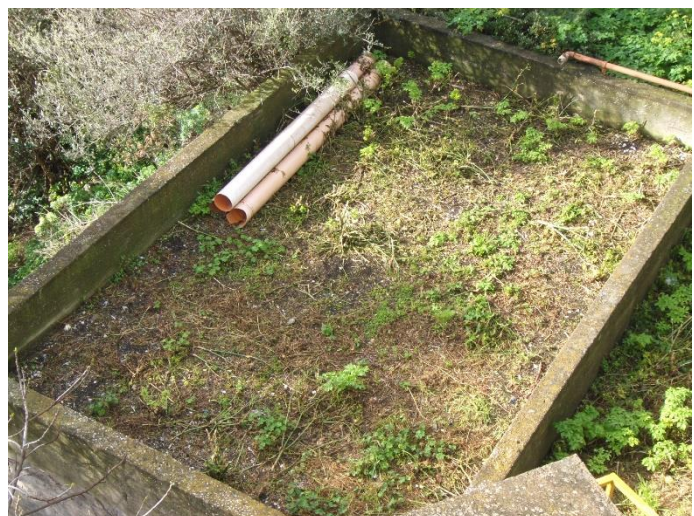
Figura 48. Letti di essiccazione non utilizzati
