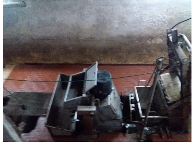
Figura 96b. Maiori Costa D'Angolo. A destra la grigliatura meccanica a sinistra la rotostacciatura.
