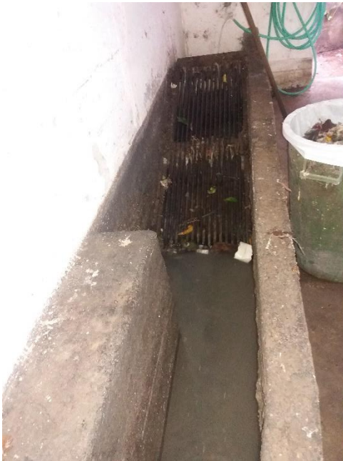
Figura 68. Impianto Ravello Marmorata. Grigliatura.
