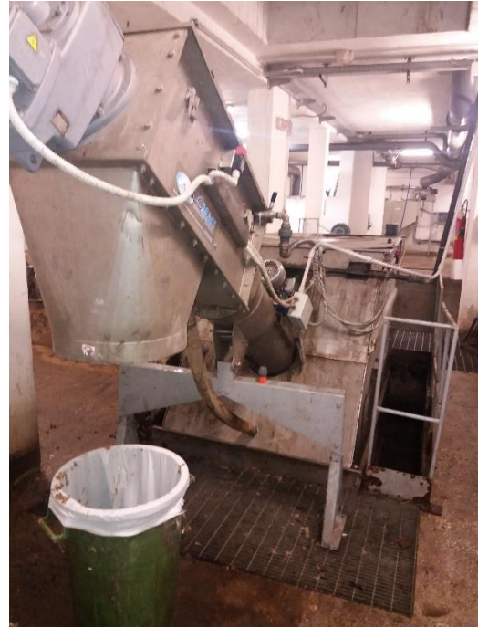
Figura 108. Vietri. Rotostaccatura.
