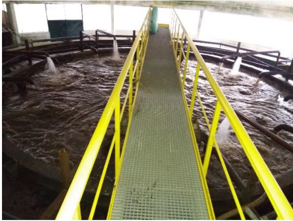
Figura 82. Impianto Minori. Ossidazione biologica e sedimentazione.
