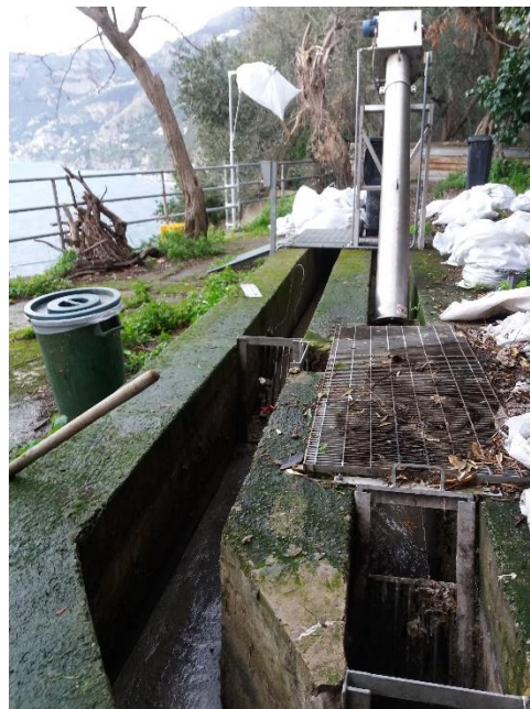
Figura 32. Impianto Praiano – Vettica Maggiore. Grigliatura-dissabbiatura.
