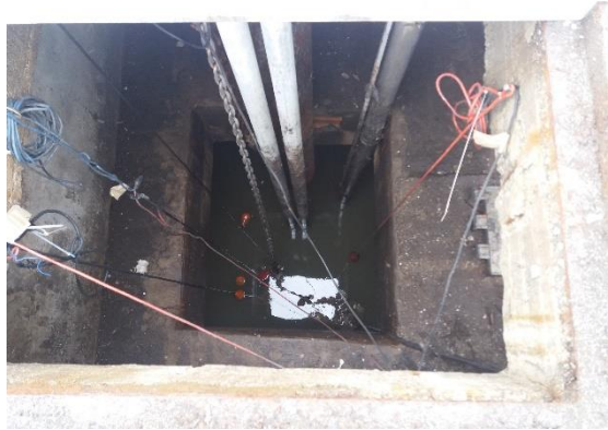
Figura 85d. Stazione pompaggio Minori. Dettaglio vasca pozzetto lato mare.
