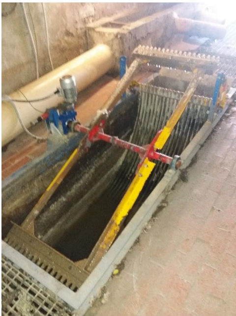
Figura 48c. Impianto pretrattamento Furore. Grigliatura automatica.
