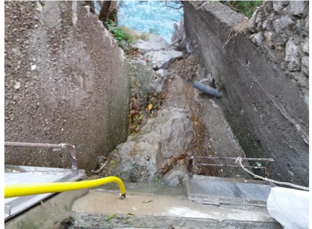
Figura 40. Impianto Praiano – Loc. Torre. Dettaglio sfioratore.
