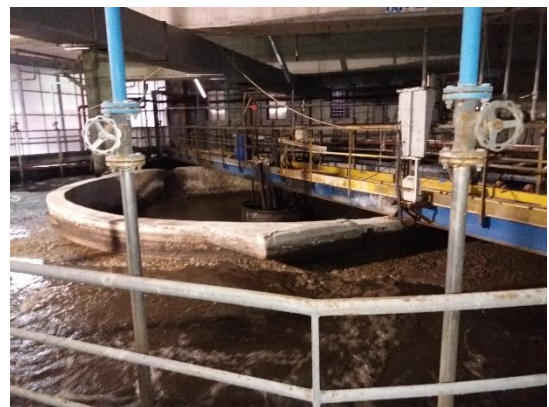
Figura 28. Impianto Positano. Linea fanghi. Stabilizzazione e ispessimento
