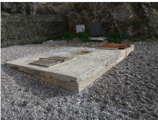
Figura 101c. Minori. Erchie. Accesso alla stazione di pompaggio in condotta sottomarina.
