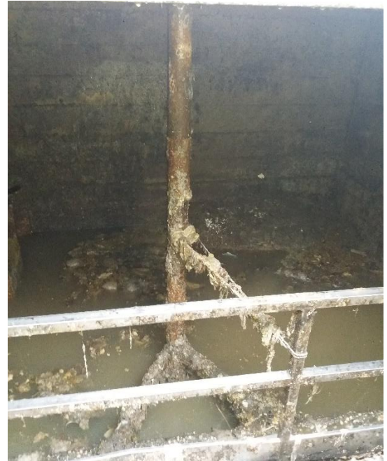
Figura 55b Impianto Atrani Piazzale Marinella. Dissabbiatura.
