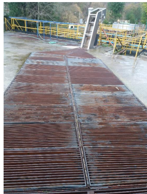
Figura 7. Impianto Agerola. Sotto le griglie è eseguita la dissabbiatura.
