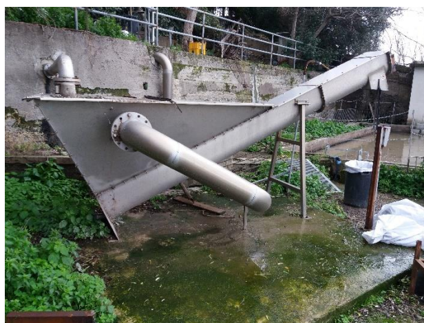
Figura 34. Impianto Praiano – Vettica Maggiore. Dissabbiatore centrifugo.
