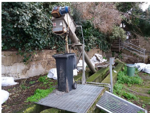
Figura 33. Impianto Praiano – Vettica Maggiore. Grigliatura e dissabbiatura a coclea.
