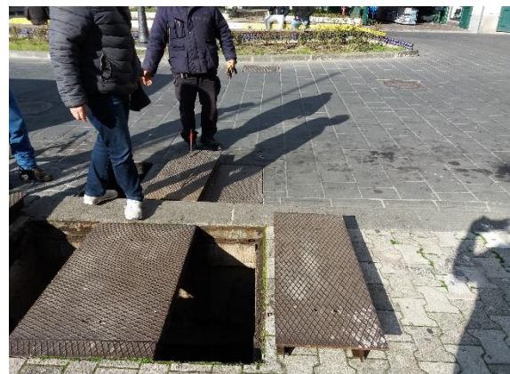
Figura 99b. Maiori Corso Reghinna. Accesso alla vasca raccolta acqua fiume e pompaggio.
