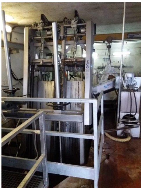
Figura 52. Impianto Amalfi. Grigliatura.
