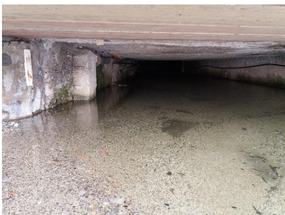
Figura 56. Atrani foce del torrente Dragone. A sinistra lo sfioro dell'impianto di pretrattamento di Piazzale Marinella.
