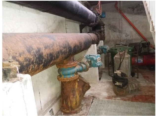
Figura 96d. Maiori Costa D'Angolo. Pompaggio in condotta sottomarina.
