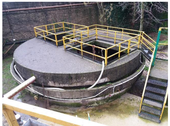
Figura 13. Impianto Agerola. Linea liquami. Ispessimento
