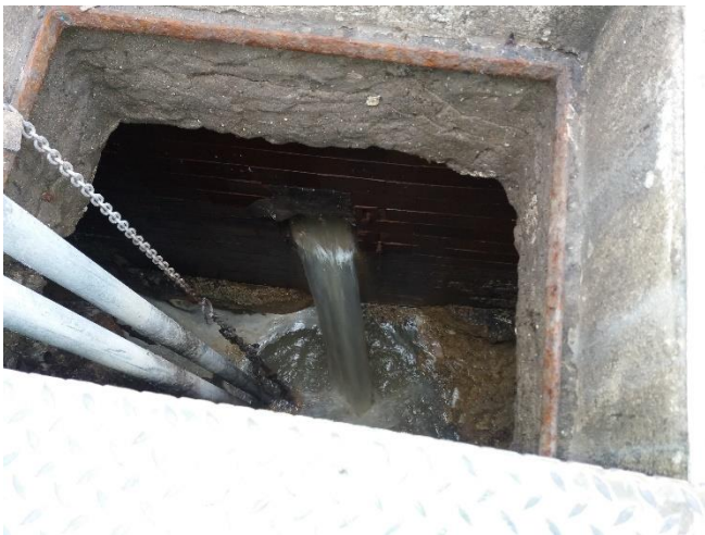
Figura 104. Cetara. Dettaglio Vasca raccolta - dissabbiatura.
