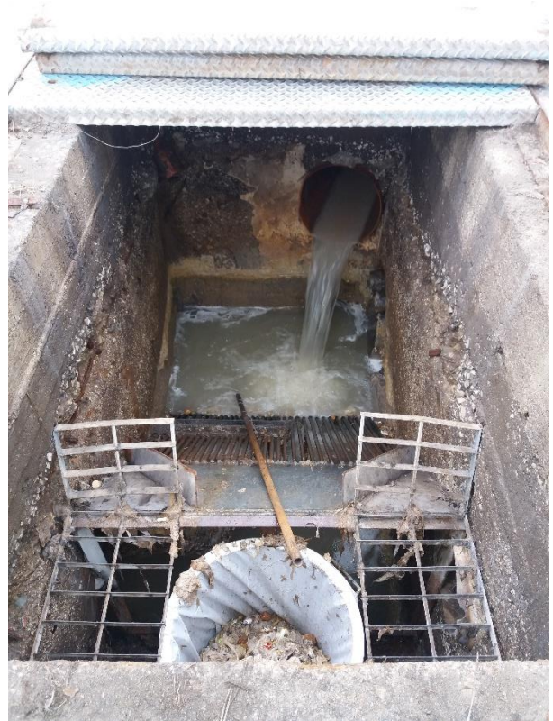
Figura 103b. Cetara. Grigliatura.
