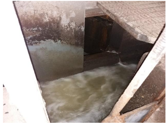
Figura 20. Impianto Positano. Ingresso impianto. Dettaglio sfioro.
