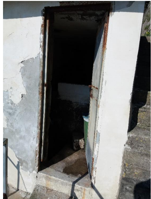
Figura 70c. Impianto Ravello Marmorata. Gabbiotto posizionato in loc. Marmorata a valle della strada statale. Dettaglio ingresso.
