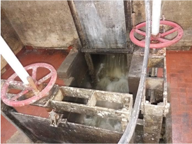
Figura 96a. Maiori Costa D'Angolo. A destra la grigliatura meccanica a sinistra la rotostacciatura.
