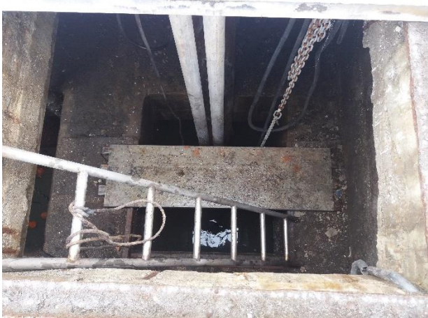
Figura 85e. Stazione pompaggio Minori. Dettaglio vasca pozzetto lato strada.
