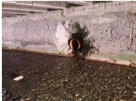
Figura 85f. Dettaglio sfioro della stazione pompaggio Minori nel fiume Regina minor.
