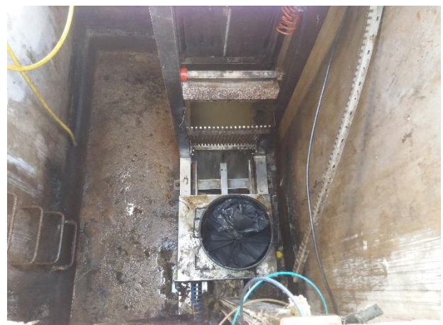
Figura 97b. Maiori via Amendola. Grigliatura.
