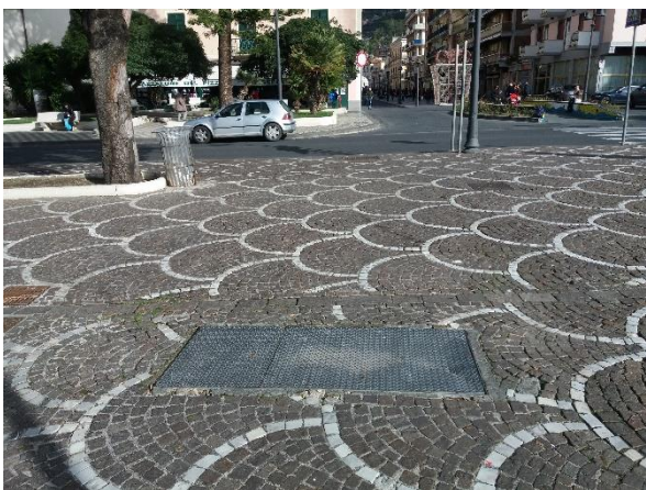
Figura 97a. Maiori via Amendola. Botola di accesso alla grigliatura.
