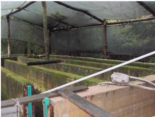
Figura 91. Impianto Tramonti. Disinfezione.
