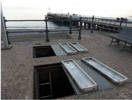
Figura 85C. Stazione pompaggio Minori. Vista generale.
