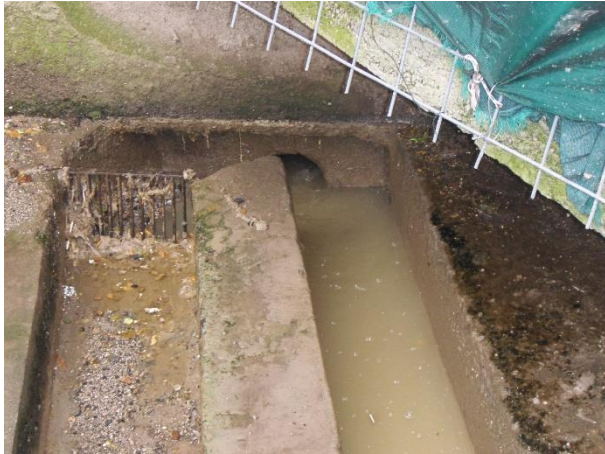
Figura 60. Impianto Ravello Cigliano.
