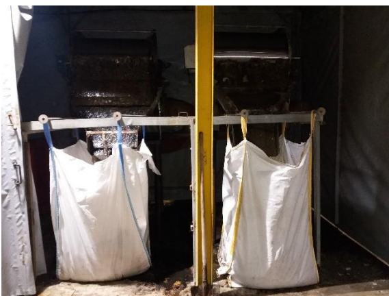
Figura 23. Impianto Positano. Rotostacciatura.
