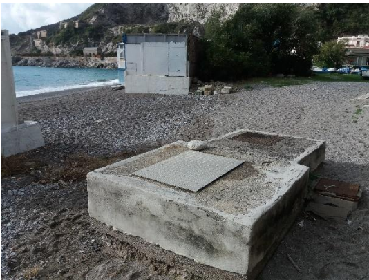
Figura 101a. Minori. Erchie. Pozzetti di accesso all'impianto di pretrattamento.
