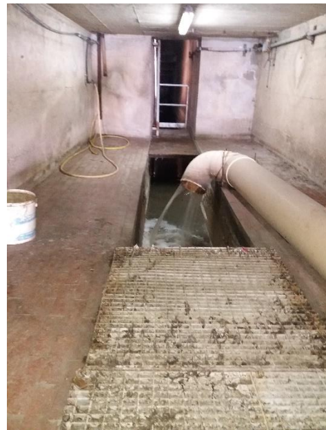
Figura 48d. Impianto pretrattamento Furore. Dissabbiatura.
