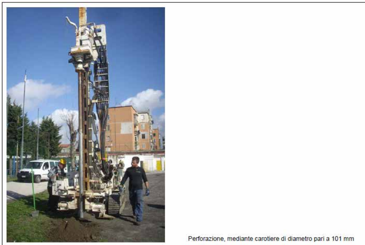
Figura 119. Perforazione mediante carotiere di diametro pari a 101 mm
